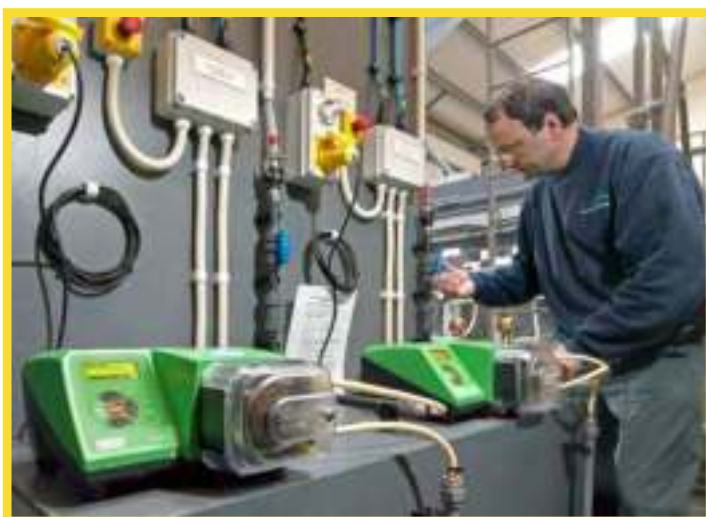
Насосы серии 500 пришли на смену ненадежным мембранным насосам, используемым для дозирования коагулирующих добавок
